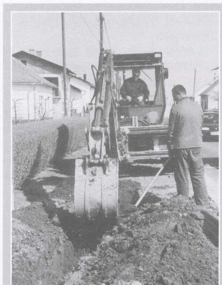
Gradbena dela na severni mestni vpadnici so bila ovira za promet, kako bo le-ta potekal v času, ko bodo skozi Mursko Soboto brzeli še prometni vlaki, pa nas upravičeno skrbi že sedaj, saj bo pretok zelo moten.
