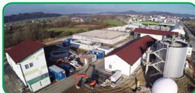
Čistilna naprava Grosuplje lahko dnevno prečisti do 7.700 m 3 odpadne vode, kar zadostuje populaciji do 20.000 prebivalcev. Očiščena odpadna voda pa odteka v potok Bičje.
