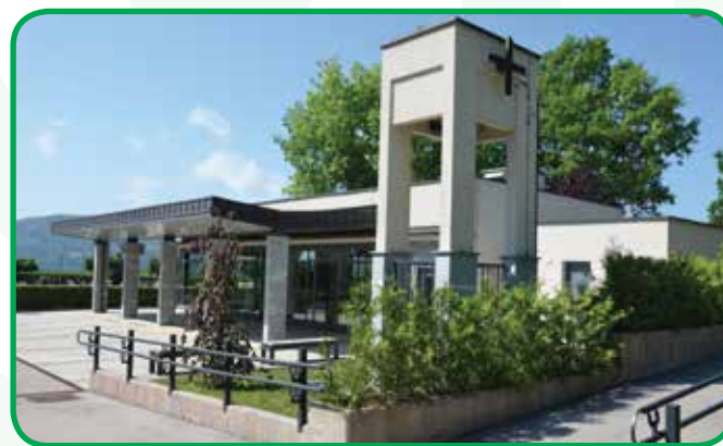
Poslovilni objekt na Mestnem pokopališču Resje Grosuplje.
