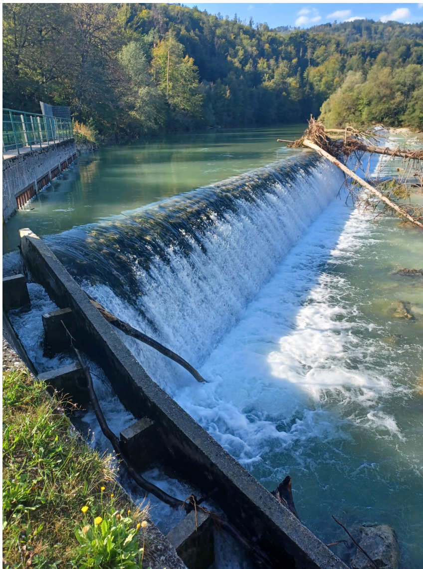
Slika 5: Degradirano področje reke Save Bohinjke na sotočju – Cajnov jez, ki zapira 35 km povezanost v območju močno zdesetkanega sulca. Foto: Revivo
