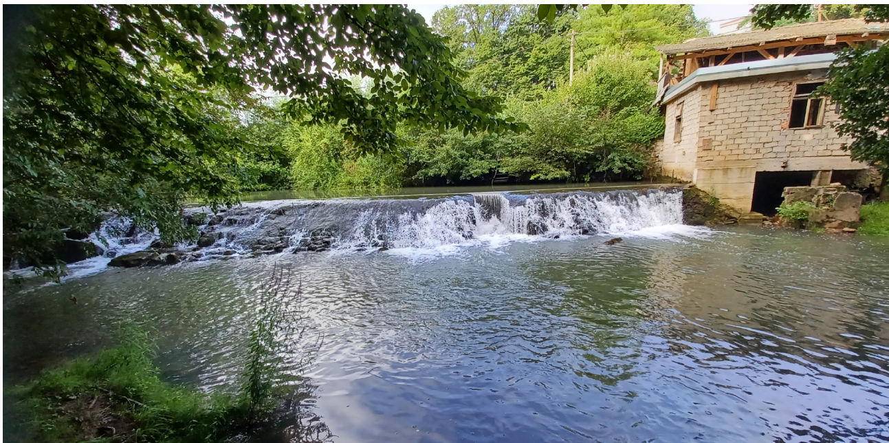
Slika 22: Prag na Težki vodi. Razpadli ostanki žage. Foto: Revivo
