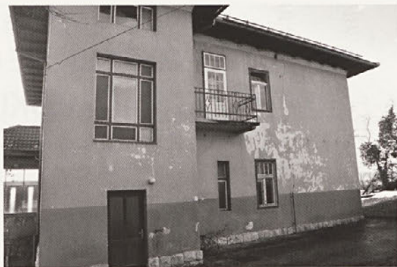
Zwitterova vila, severno pročelje, marec 2013. (Foto: Rasto Božič)
