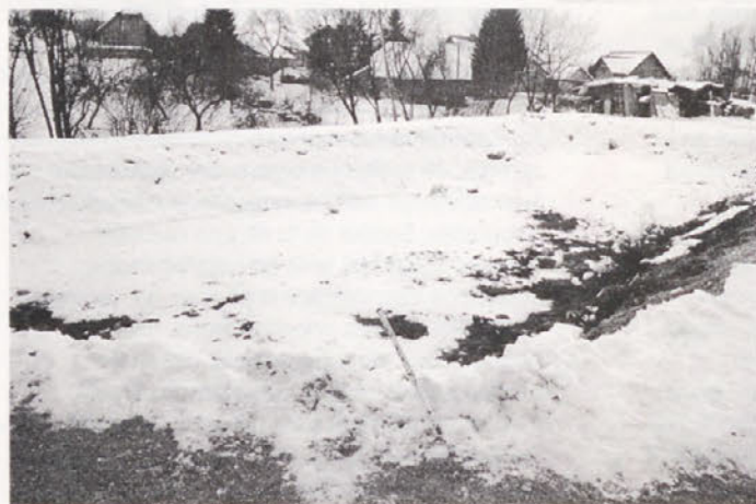
izkop za bazen pred hišo
