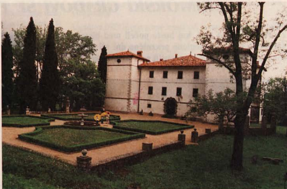
Grad Kromberk je bil v celoti rekonstruiran ob koncu sedemdesetih let. Osrednjo stavo obdajajo na vogalih štiri stolpi kvadratnega tlorisa. V njem domuje Goriški muzej.
