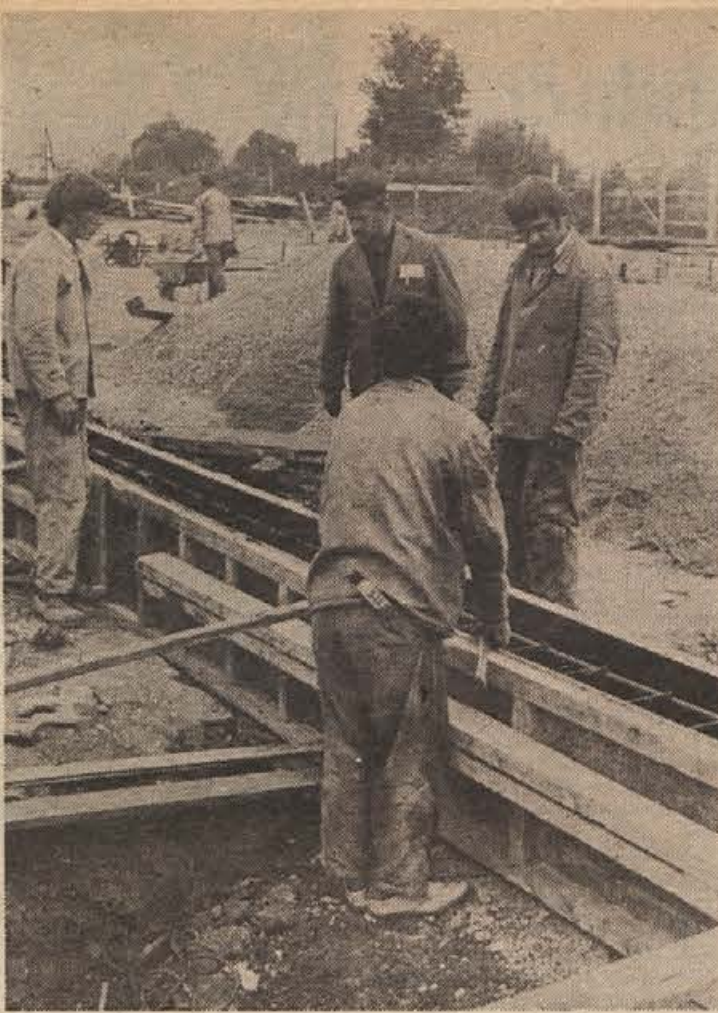
Podjetje „Slovenija-cesta“ iz Ljubljane gradi v Brslinu, nedaleč od garaž avtobusnega podjetja „Gorjanci“, med železnico in cesto, ki drži proti Bučni vasi, veliko skladišče za ljubljansko carinarnico. Kot so povedali, potekajo dela po načrtu. Zdaj urejajo temelje. (Foto: I. ZORAN)
