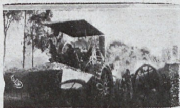
Lokomobil za pogon mlatilnice lana (trilladora).
