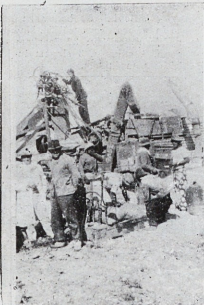
„Desgranadora“, stroj za zrnjenje kukuрузa, koji za 10 radnih sati izljušti nad dve tisuće kvintala kukuрузa.
