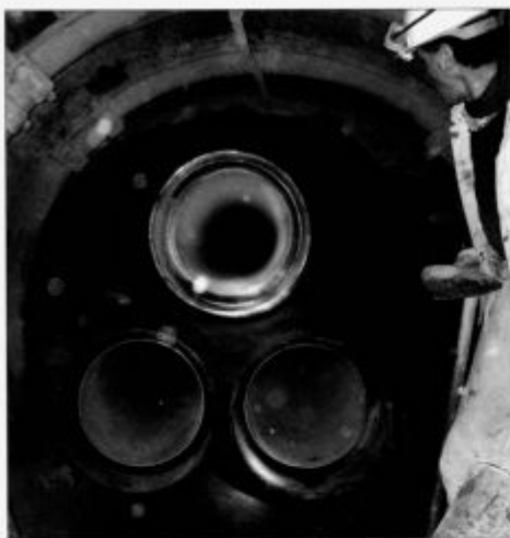
Izgradnja vodnega zbiralnika na IX. obzorju (T. Dizdarevič, 2004)
