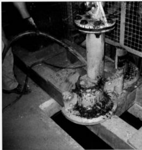
Montaža novih potopnih črpalk in cevovoda v jašku Borba (R. Majnik, 2005)
