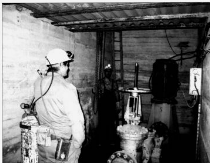
Demontaža črpališča na XI. obzorju (M. Lukan, R. Majnik, 2005)
