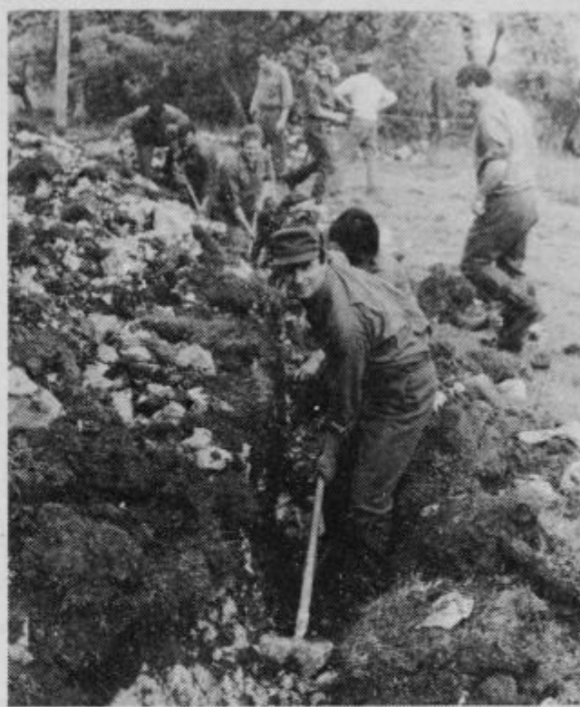
V Studencah so vojaki in starešine kopali jarke za vodovod
