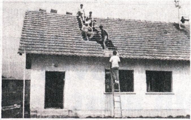
Prekrivanje strehe na Kulturnem domu
