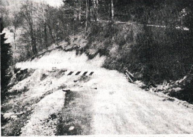
Obnova ceste Špitalič – Nova Reber in poškodovani del cestišča
