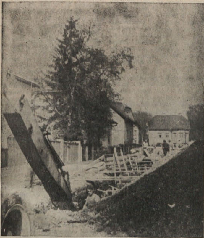
Dela pri polaganju toplovodnega omrežja v Proletarski ulici dokaj hitro napredujejo
