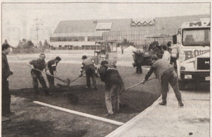
BREŽICE DOBIVAJO ATLETSKI STADION - Brežiška atletika, ki spada med najuspešnejše v državi, si te dni zadovoljno mane roke. Na novem stadionu pri srednji ekonomski šoli te dni na asfaltno osnovo polagajo umetno maso. Črni spodnji del je nemškemu podjetju Politan, ki je prekrilo tudi novomeški štadion, že uspelo položiti, za dvojni rdeči vrhnji del pa je mojstrom zmanjkalo lepega vremena. Če bo do tedaj vsaj pet dni ugodnega vremena, bo stadion slovesno odprt že 19. novembra. Gradbena dela je opravilo podjetje Posavje iz Sevnice, asfalt je položilo novomeško Cestno podjetje, celotni projekt pa bo stal okoli 100 milijonov tolarjev; dobro polovico tega bosta plačala ministrstvo za šolstvo in šport in sklad za gradnjo športnih objektov pri olimpijskem komiteju Slovenije. (Foto: I. V.)
