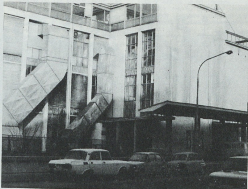
Prezračevalne naprave v Kartonažni tovarni LJUBLJANA
