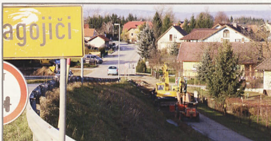
Vremenske razmere omogočajo nemoteno nadaljevanje del na kanalizacijskem omrežju
