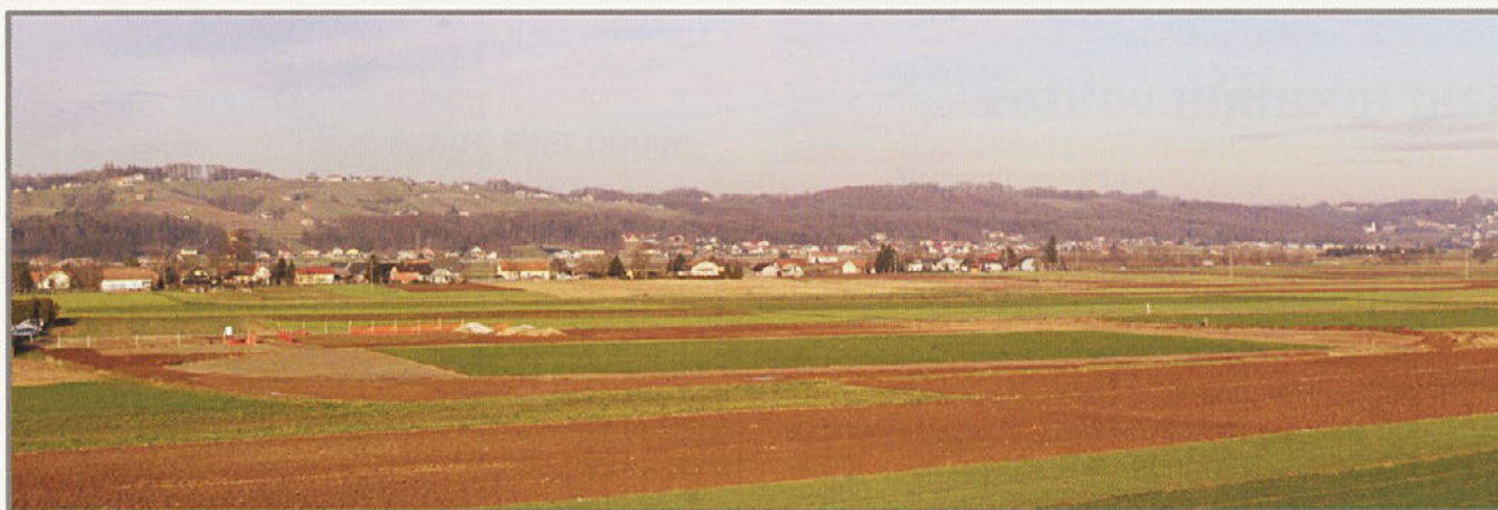
Zemeljska dela na novem nogometnem igrišču
