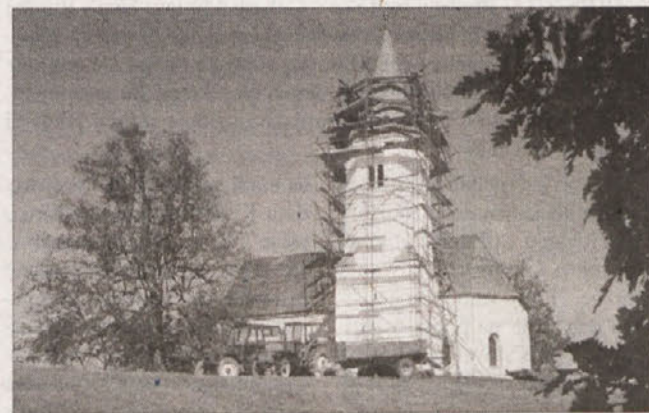
ZVONIKU VRNILI STARO PODOBO - Krajan Razborja in okoliških zaselkov so obnovili zvonik cerkve sv. Lovrenca, ki ga je med drugo svetovno vojno poškodovala strela. Takrat so ga zasilno prekrili, tako pa je ostalo do letos. Zdaj so zvoniku vrnili staro podobo, namesto s kamnom pa so ga prekrili s pohorskim škrljcem. (Foto: Franci Pavkovič)
