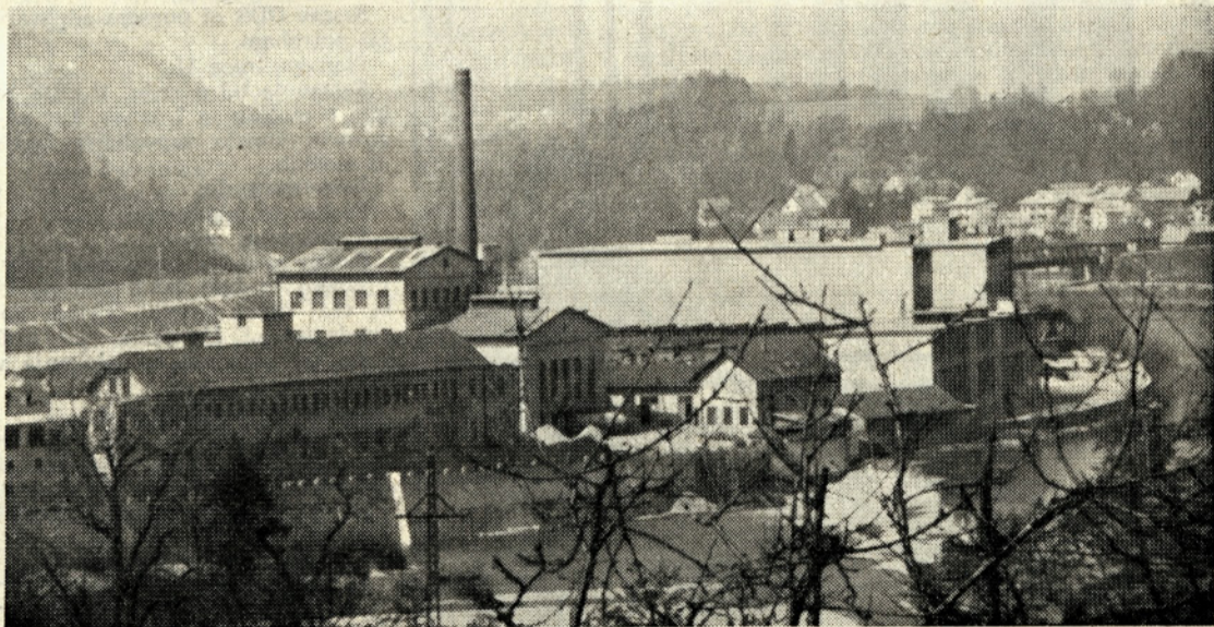
Pogled na termoelektrarno in na prizidek predilnice v obr. I.
