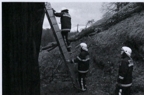
Prekrivanje strehe po silovitem novembrskem vetru.
