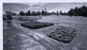
Rastlinska čistilna naprava
