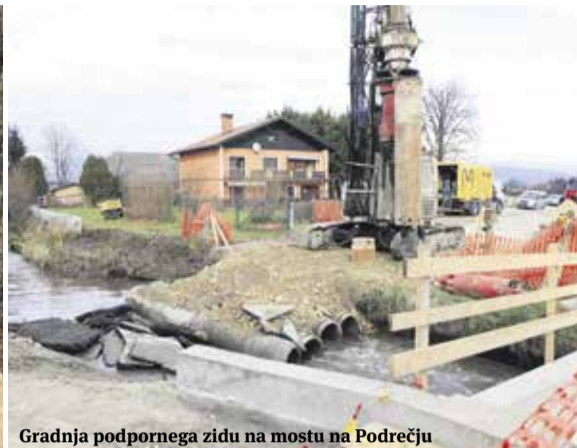
Gradnja podpornega zidu na mostu na Podrečju
