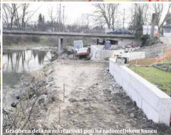
Gradnja podpornega zidu na mostu na Podrečju
