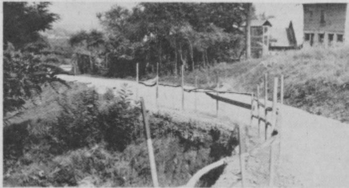
Poškodovani del ceste na Ptujsko goro
