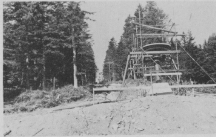
Zaključna dela pri gradnji vlečnice pri Treh kraljih
