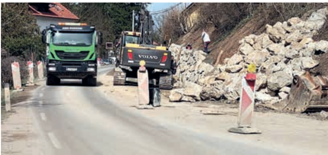
Gradnja opornega zidu na Bregu.
