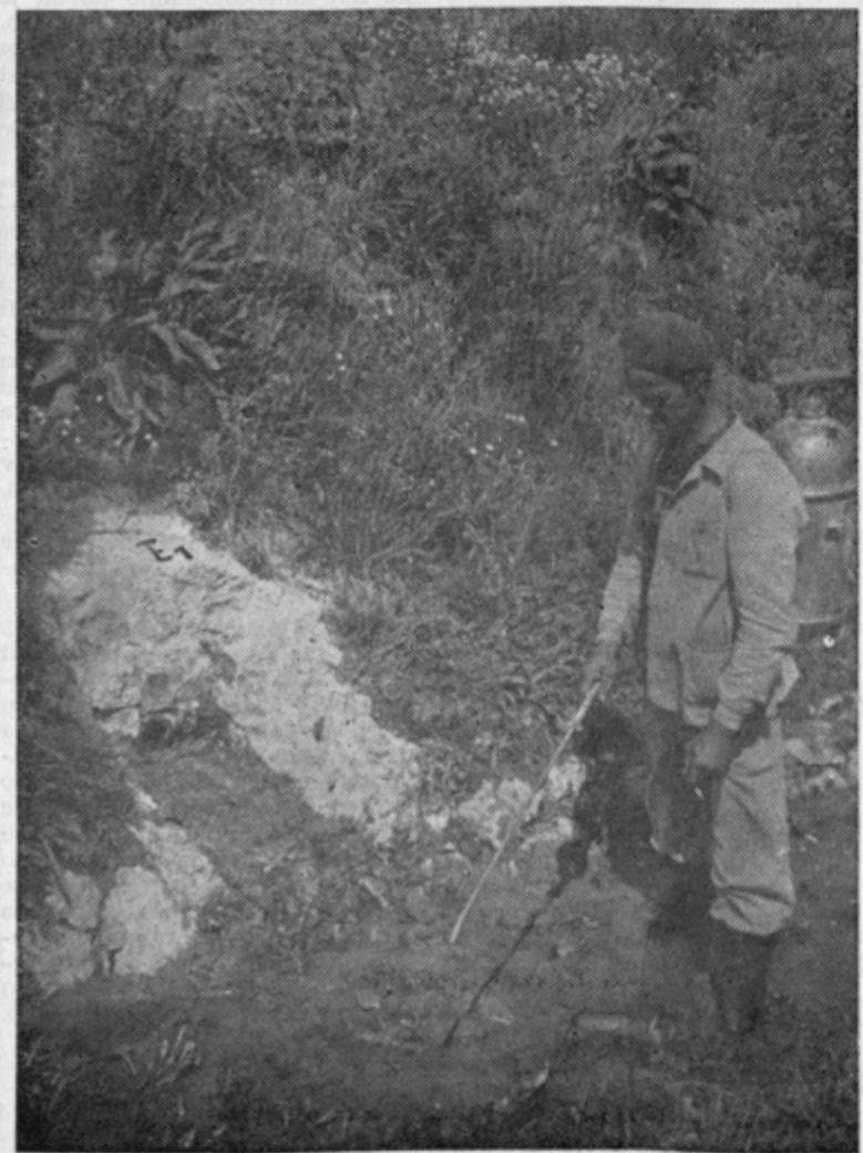
Izlivka cevne drenaže in kemično uničevanje plevelov v odvodniku
