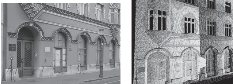
Slika 7: Različni materiali in različna odbojnost: fotografija (levo), skenirano (desno) (vir: Geoservis, d.o.o.).
