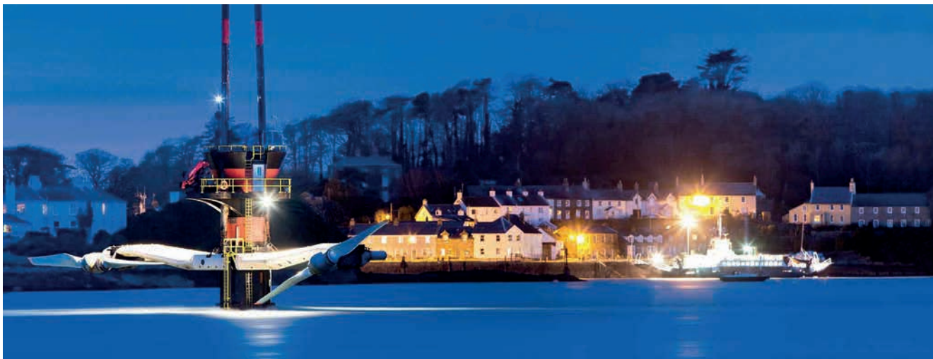
» Električna energija iz plime: Elektrarna SeaGen na obali Severne Irske je podobna elektrarni na veter, pri čemer je postopek izjemno učinkovit, ker je voda 800-krat gostejša od vetra (zraka).
