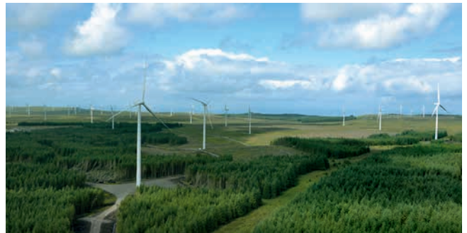
» Hitra Ethernet komunikacija skupaj s pripadajočimi krmilnimi in nadzornimi sestavinami zagotavlja nemoteno dobavo električne energije mestu Glasgow na Škotskem z razširjene verige vetrnih elektrarn. Slika prikazuje skupino stotih Alstomovih ECO vetrnih elektrarn. (© Slika: Alstom, Francija)
