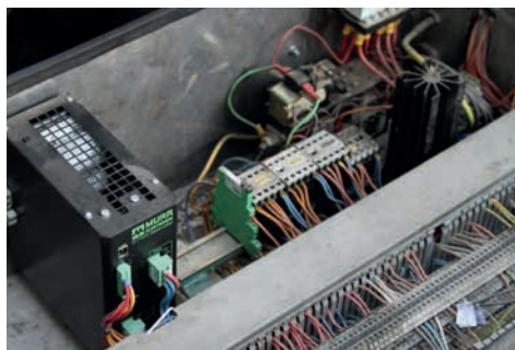
» Slika 6. Modul MB Cap za preprečevanje kratkotrajnih prekinitev napajalnih napetosti
