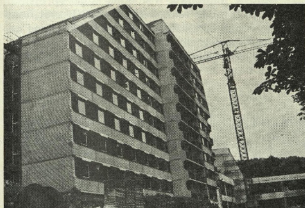
Gradnja hotela v Dobrni
