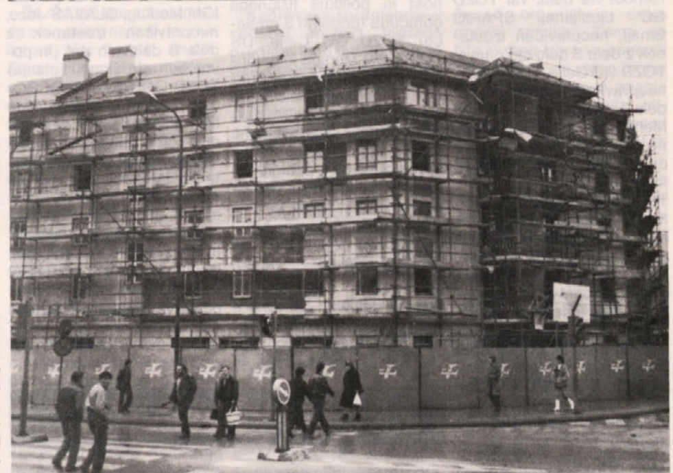
Poslovno stanovanjski objekt v Levstikovi ulici bo lepo vključen v celjsko mestno središče. Izvajalec GO Celje. Foto Vili Š.
