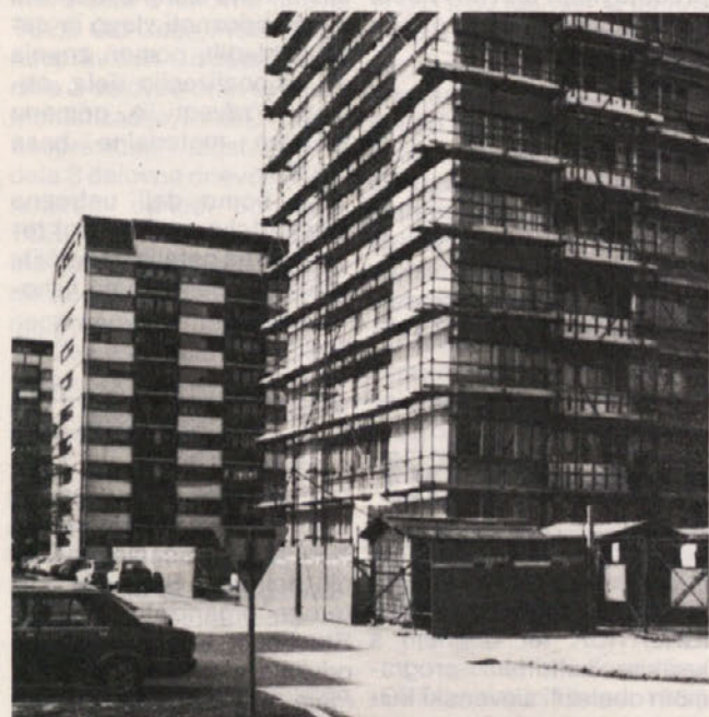
Nadaljujejo se obnovitvena dela na fasadah in strehah stanovanjskih objektov Jugomont. Izvajalec GO Celje.
