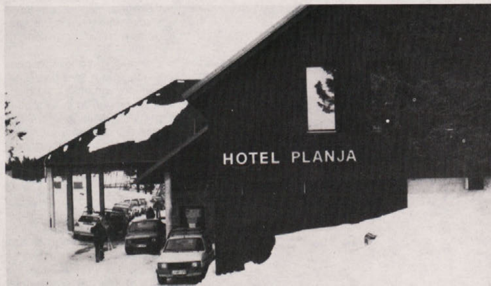
Nov večnamenski objekt hotela Planja na Rogli je lani pravočasno zgradila GO Celje.
