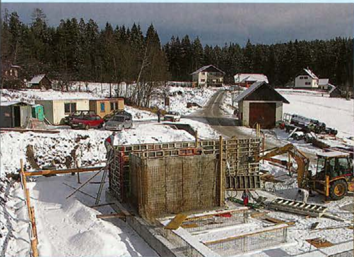
Odlagališče odpadkov Lokovica
