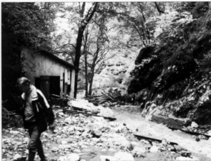
V severnem delu soteske, levo poškodovana baraka št. 9 – skladišče, 19. 9. 2007
