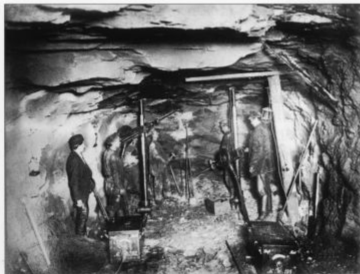
Poskusno vrtanje z električnimi stroji v začetku 20. stoletja (fototeka MMI)
