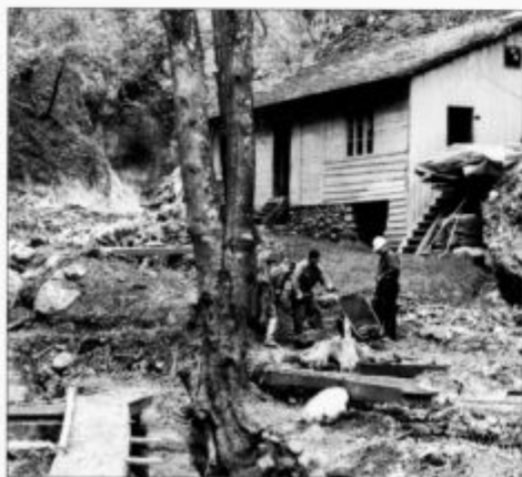
Pokazali so se ostanki temeljev, mostički, škarpe..., 23. 10. 2007.
