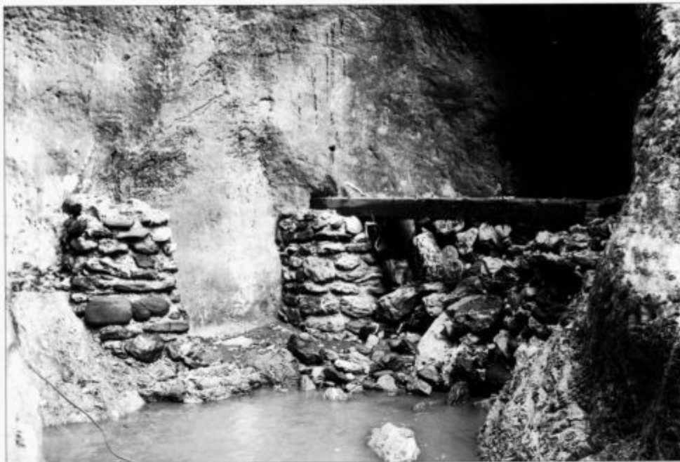
Od električne centrale so ostali sledovi temeljev, 4. 10. 2007
