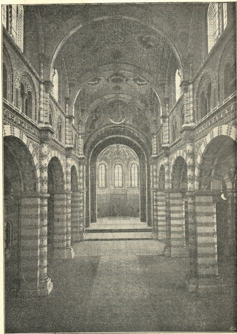
Die Innenansicht der neuen Pfarrkirche.
