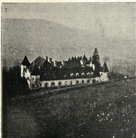
Ansicht des Schlosses Freibüchl von Nordosten.
