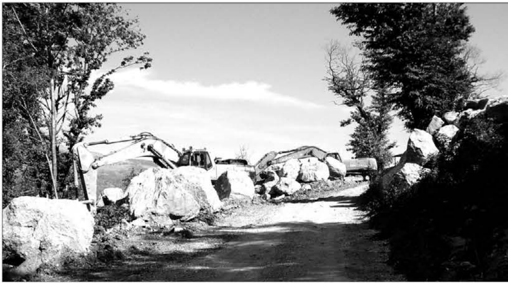
Lavori nella cava di Altovizza
