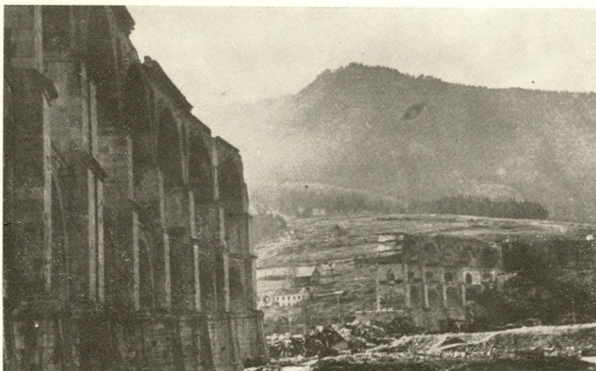
Še posnetek mostu s strani
