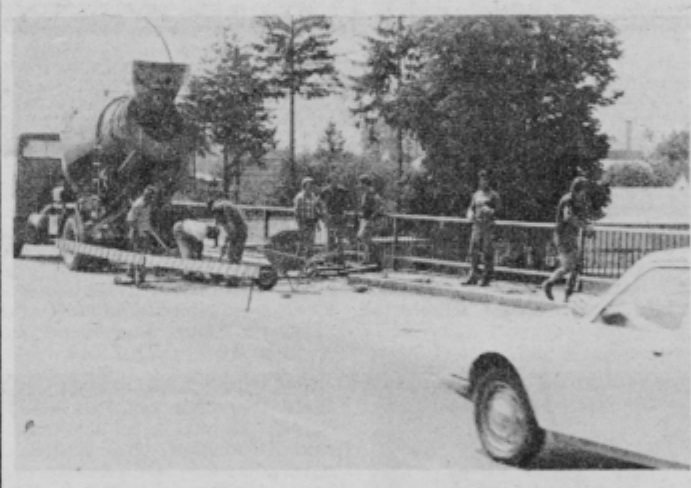
Zaključna obnovitvena dela prve tretjine ptujskega mostu. posnetek: B. Vodusek
