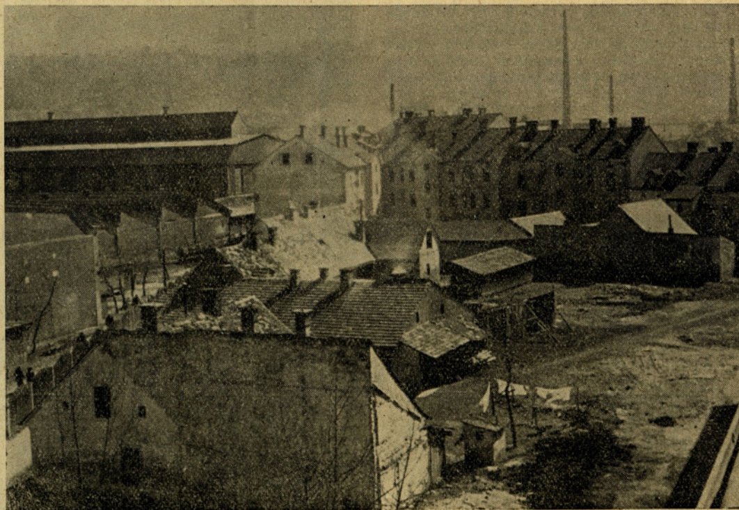
Dotrajale stanovanjske zgradbe bodo morale dati prostor novim tovarniškim proizvodnim obratom
