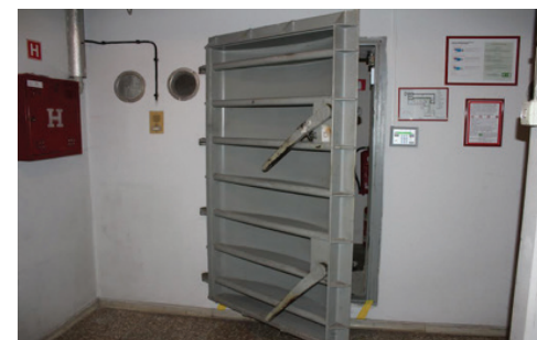
Vhod v podzemno skladišče orožja takratne milice v Murski Soboti.
