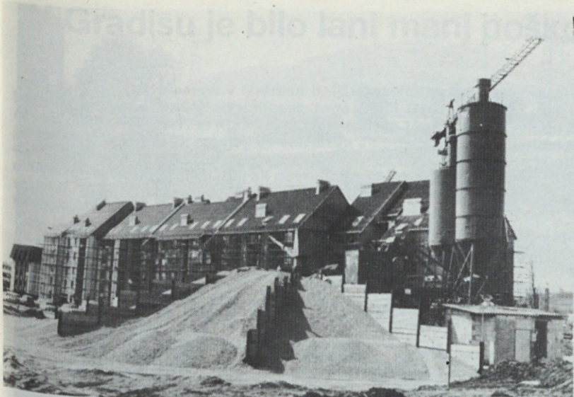
V končni fazi gradnje je tudi stanovanjski blok B — 2
