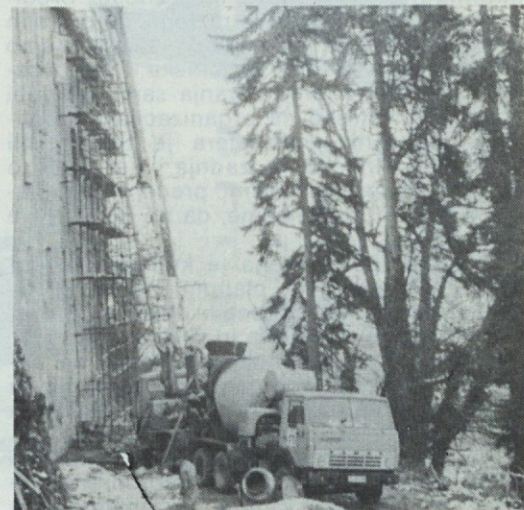
Tudi v zimskih razmerah smo betonirali
