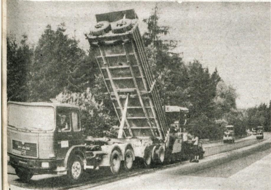
Nova asfaltna prevleka na gorenjski cesti — Delavci Cestnega podjetja Kranj so že uredili štiri odseke na magistralni cesti Črnivec—Podtabor, v dolžini skoraj pet kilometrov. Dela so veljala 140 milijonov dinarjev, denar pa je prispevala republiška skupnost za ceste. Naslednji cestni odsek, ki ga bodo obnovili delavci Cestnega podjetja, bo odsek Korensko sedlo—Log pri Kranjski gori. — Foto: F. Perdan
