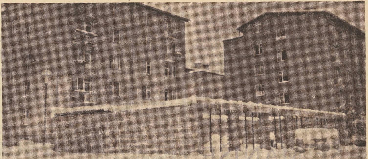
Z naraščajočo motorizacijo se je razumljivo povečala tudi potreba po novih garažnih prostorih. Prav je torej, če lastniki avtomobilov grade garaže, toda ne v neposredni bližini stanovanjskih blokov, na škodo zelenega pasu in otroških igrišč. Tak primer imajo tudi na Zlatem polju v Kranju, kjer so že do sedaj postavili več kot 50 garaž v neposredni bližini stanovanj. Ali mora res vsakdo imeti garažo pod svojim oknom?
