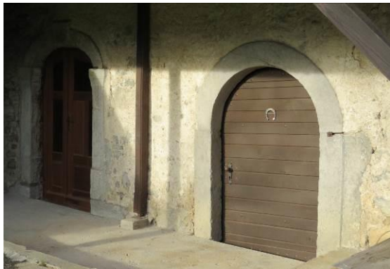
Slika 27: Desno morda starejši tip portala v klet pred 1820-im letom – polkrožni zaključek na eni od zadnjih strani hiše v središču Brod Moravic. Levi vhod v stanovanjski del je bil vgrajen 1834. leta.
