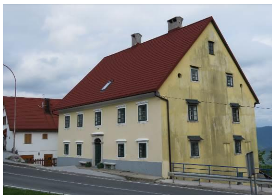
Slika 389: Velika Lončarićeva hiša (18x13,5m) stoji že več kot dve stoletji ob glavni tranzitni cesti - Luiziani.
