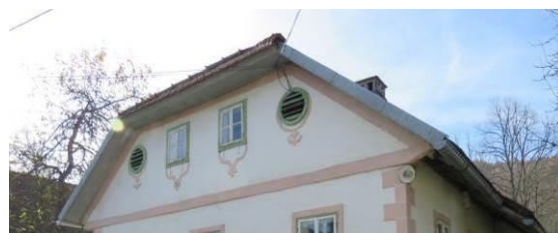
Slika 92: Okrasje zgornjega dela zatrepne fasade, izdelano iz ometa, je ostalo še staro.
