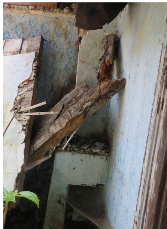
Slika 365: Zaradi lesenih stropnikov so bile naknadno izdelane peči in štedilniki močno pritisnjeni k zidu. Pozidani iz opek in ometani.
