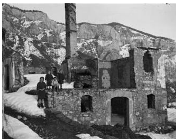
Slika 303: Fotografija požgane hiše Nakuončne in družine brez očeta. Levo od hleva je hiša imela za gnojiščem lepo izdelan kamniti oporni zid s klančino do hišnega vhoda s portalom, ki je ostal originalen. Že v nekaj mrzlih zimah brez strehe je omet sten odpadel. Foto: Edi Šelhaus, leto 1945.
