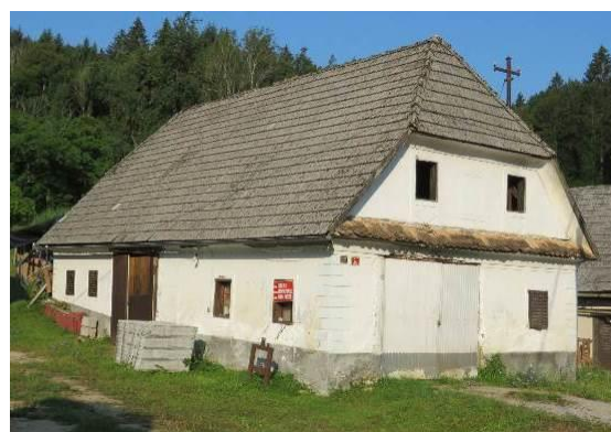
Slika 339: Krajerševa hiša, Občice 2 je ena od enovitih stavb v Občicah, pritlična, zadnji del zidan, sprednji lesen iz tesanih gred, spojenih na lastovičji rep, verjetno iz začetka 19. stoletja. Predelana je v garažo. Okenci na podstrehi sta služili odvodu dima. Z zadnje strani se je na podstreho lahko nalagalo seno.
