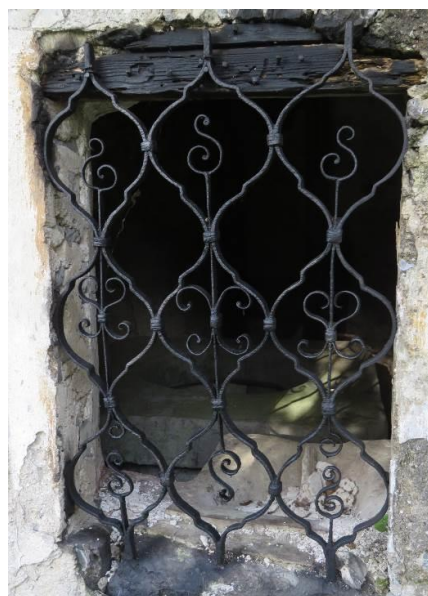
Slika 38: Ena od redkih kovanih mrež, ki smo jih odkrili v Brod Moravicah, je na štirni pri županovih, a je bila tja prinešena verjetno iz stanovanjske hiše, kjer je zapirala vežno prezračevalno okno na vhodni fasadi poleg vhodnih vrat. Verjetno še iz konca 18. stoletja.
