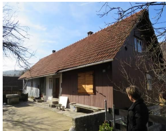
Slika 73: Hiša klesarjev, bratov Majetić v središču Malih Drag, dve družini pod eno streho.
