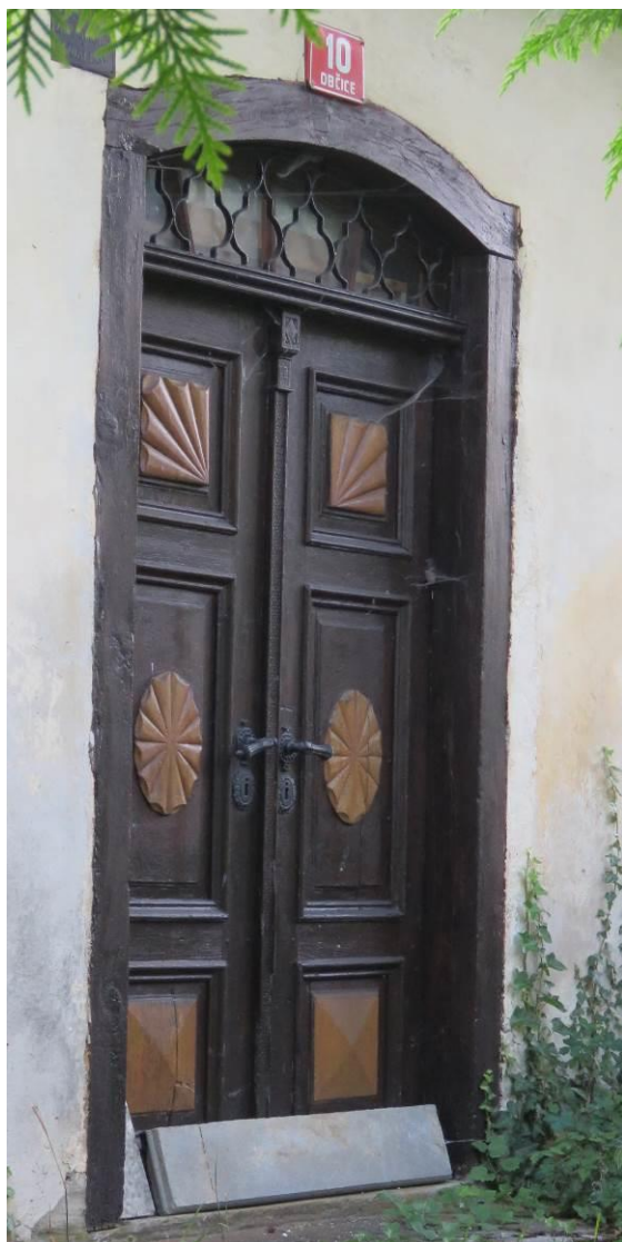
Slika 358: Jarmičasti leseni portal in vrata iz Občice, druga polovica 19. stoletja. Zgoraj z neobaročnim okovom za zračnik.
