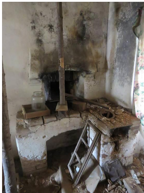
Slika 351: Kuhinjski kot v nadstropju hiše Občice 3, desno je naknadno prizidan mali štedilnik z obroči- dimnik je v kotu.
