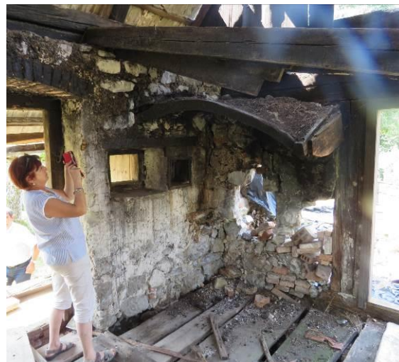
Slika 364: V sredini kot v veži s kuriščem na ozki polici pred ustjem peči. Levo v steni mala niša za sol in kuhinjsko orodje, zraven okence za svetlobo. Nad ognjiščem je ukrivljena napa za lovljenje isker, ometana z glino.
