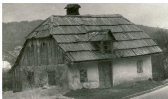
Slika 534: Še ena nekdanja hišica iz Zbitkov. Enotraktne osnove, morda nekdanj ognjiščna. Na sliki že predelana v hišo z masivnim dimnikom zadaj.
