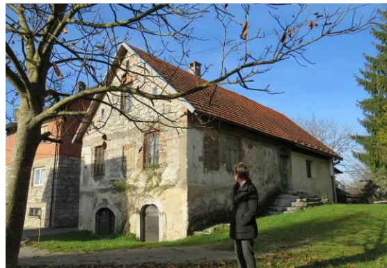
Slika 33: Zidana stanovanjska stavba nekdanjega župana v Brod Moravicah, nekdanj s tremi okni na zatrejni cestni fasadi in dvema vhodoma v kleti s kamnitima portaloma.
