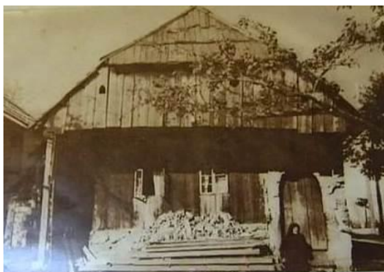
Slika 121: Sprednja stran hiše Delač pred temeljito rekonstrukcijo v 1970-ih letih (vir zbirka v hiši). Obnova je žal izbrisala marsikateri stari detajl.
