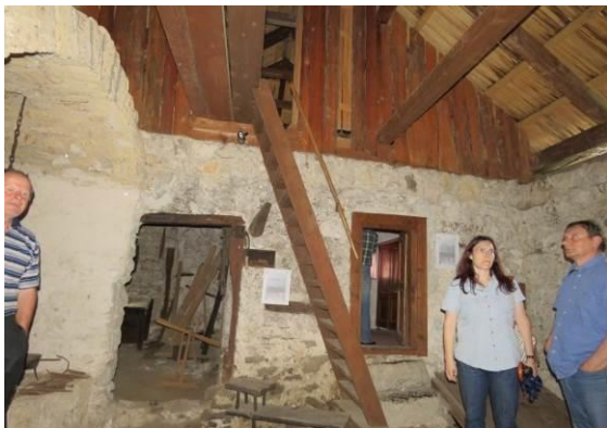
Slika 124: Razširjeni in v podstreho odprti osrednji del hiše Delač s prostorom za živali in vhodi v kaščo in klet pod njo (desno), delavnico in drvarnico levo, podstreho za otavo in seno. Levo je niša za ognjišče z obokanim stropom za lovljenje isker.
