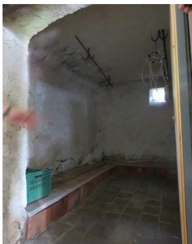
Slika 350: Plitvo obokana klet v hiši Občice 3. Betonski tlak, levo podest za sode.
