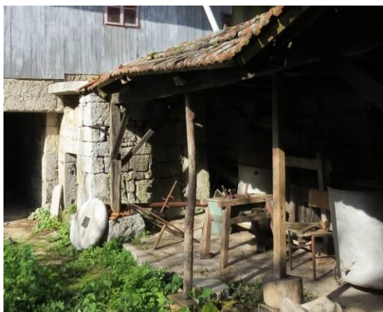
Slika 76: Mali kurnik ali svinjak iz velikih kamnitih blokov ob nadstrešku za klesarsko delavnico.
