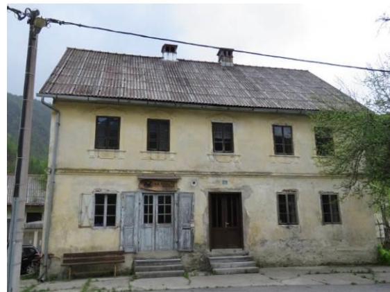
Slika 181: Meščanska hiša pri mostu iz konca 19. ali začetka 20. stoletja. Dražje, kamnite okvirje vrat so nadomeščali leseni.
