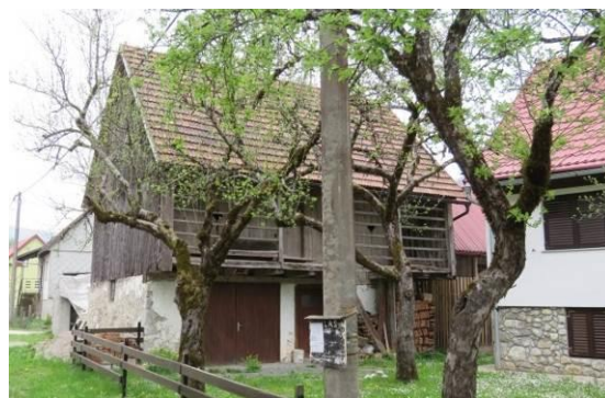
Slika 171: Tipično gospodarsko poslopje doline, s hlevom in kolarnico v zidanem pritličju, ter naprej pomaknjanim zgornjim lesenim nadstropjem senika s prislonjenim kozolcem.
