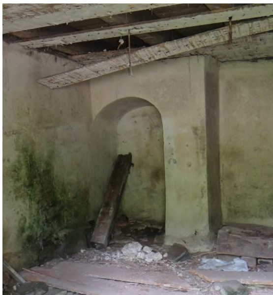
Slika 242: Podobno kot je nakazano mesto in oblika ognjišča, je v drugem kletnem prostoru izvedena vitka baba – podstavek za peč v zgornjem nadstropju. Strop je brez obokov, držijo ga močni tesani stropniki.
