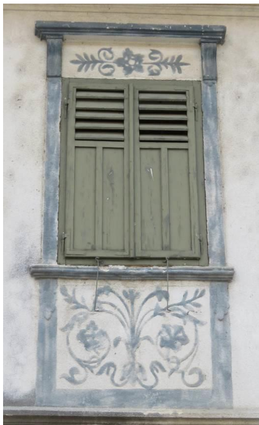
Slika 377: Eno od z ometom okrašenih okvirjev oken v nadstropju Höfferletove hiše.
