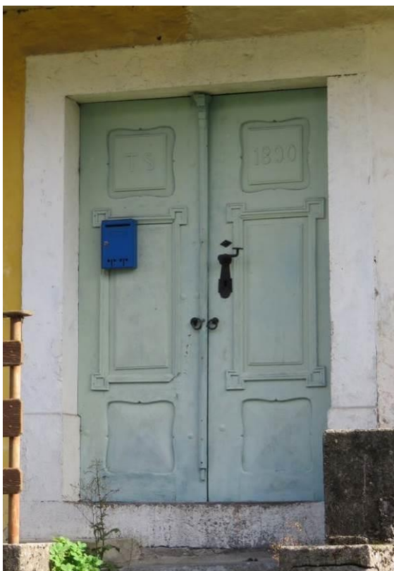
Slika 95: Vrata iz 1890. leta, iz središča vasi. Kombinacija starejših obrezanih robov in v sredini vrat, profiliranih okvirjev.
