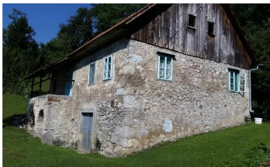
Slika 204: Petrova hiša z JV strani, nekdanj je imela zatrepna fasada tri manjša okenca. Spodnji vhod v štalo je bil izveden šele v sredini 20. stoletja. Prej so bila tam le mala okenca brez gajter.
