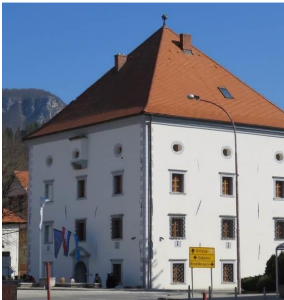
Slika 151: Po izklesanih delih izstopa graščina, opremljena z monumentalnim portalom, profiliranimi okenskimi okvirji, strelnimi linami in kamnitimi konzolami iz 17. stoletja.
