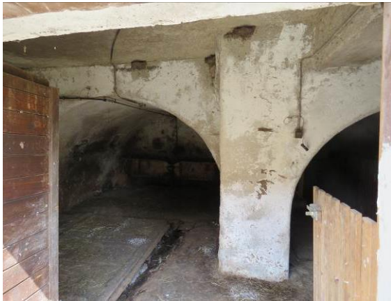
Slika 292: Leva oboka kleti Marinkine hiše, kjer je bila štala; sprednji betonski strop je bil nekoč lesen.
