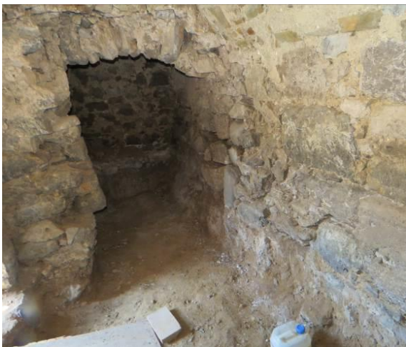
Slika 301: Pogled proti malemu prostoru, ki proti zunanji steni opira širok obok v štali (za desno steno). V desni steni je vidna gradnja iz velikih apnenčastih blokov.
