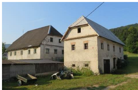
Slika 348: Nadstropna hiša Občice 3, desno. Preklade nad okni in vrati so dekorativno izvedene iz opeke.
