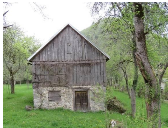
Slika 166: Mlinska zgradba v Grbajelu, mlinska kolesa so bila desno, s podlivom.
