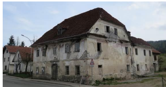
Slika 502: Za pokopališčem nas s kranjske strani pričaka velika hiša furmanske gostilne iz 1840-ih let. Zgornje nadstropje je leseno, zadnji del je močno dozidan s prenočišči.
