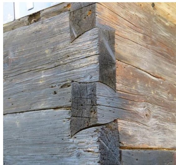
Slika 85: Natančno, mojstrsko spajanje debelih žaganih jelovih gred na dvostransko zavrt lastavičji rep - Nemški vugel .
