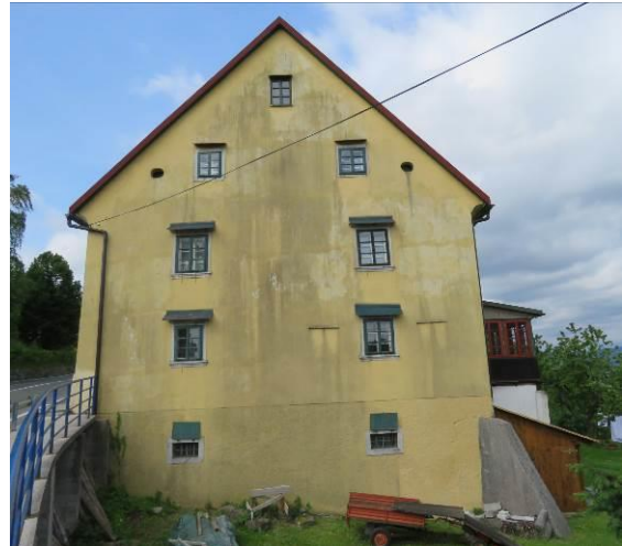
Slika 392: Monumentalna vzhodna fasada je nekoč imela streho na čop, ki jo je optično nižala. Visoka je skoraj 19 m.
