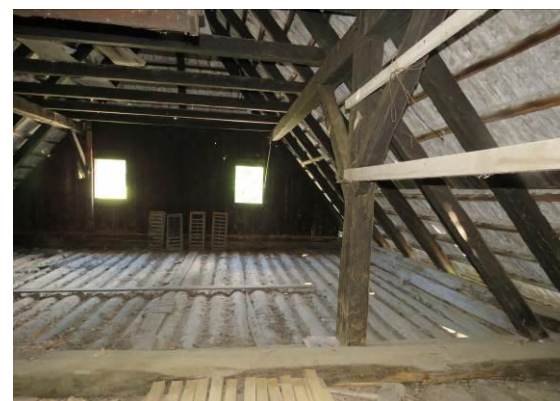
Slika 343: Vitko ostrešje na stol kaže, da je bilo prvotno pokrito s skodlami. Spodaj strop, sestavljen iz vzdolžno na pol prerežanih oblic.
