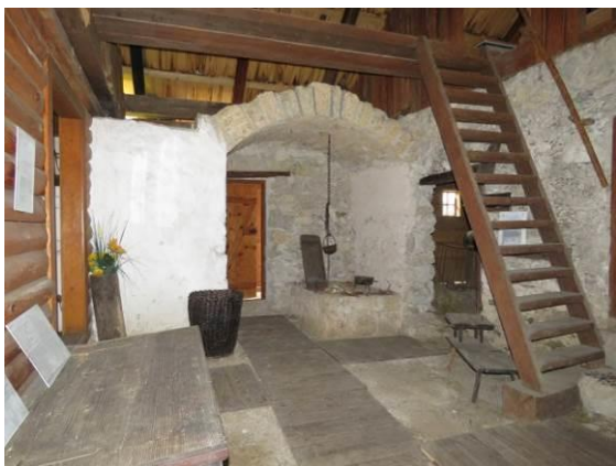
Slika 125: Kuhinjska niša, ki je del osrednjega prostora, z dvignjenim kamnitim ognjiščem in levo, zidanim ostenjem z odprtino za nalaganje peči v hiši. Obok nad ognjiščem je izdelan iz lehnjaka – ali je bil tudi originalen iz tega kamna?
