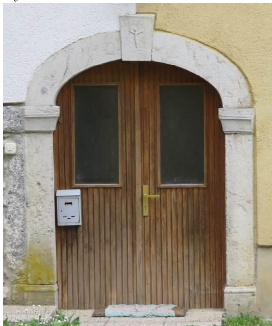
Slika 169: Portal zgornjega objekta iz leta 1836 s profiliranimi robovi in razpelom.
