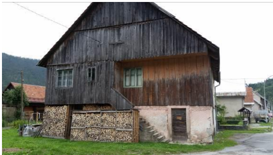
Slika 552: Stranska fasada ene od večjih vrhhlevnih hiš, ki je deljena na pol.
