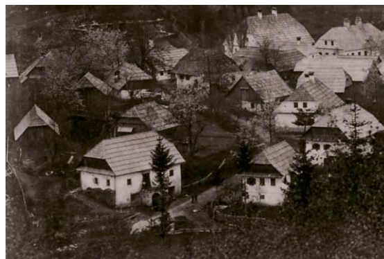
Slika 544: Izsek iz celostranske fotografije, hiše v zgornjem delu Trstja. Širše, dvotraktne, veliko jih je še brez dimnika, postavljene z vzdolžno fasado proti poti. Z zidanimi ganki, leva tudi z obokanim. Kot bi gledal koroško ali gorenjsko vasico iz 19. stoletja.
