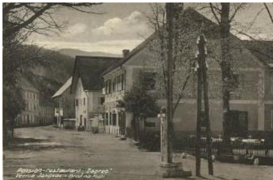
Slika 147: Razglednica Broda izpred 2. svetovne vojne. Desno je zgradba sedanjega hotela Mance, pred njo gostinski vrt.
