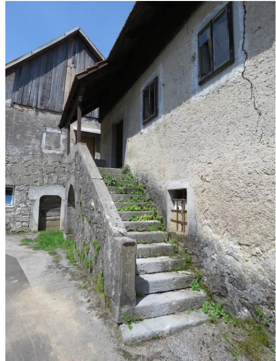
Slika 20: Ena od zanimivejših starih hiš v Gorici pri Lokvah s kvalitetno obdelanimi kamnitimi gradbenimi elementi iz 1822. leta je verjetno delo primorskih kamnosekov. Klet za krompir je bila v tla v hiši izkopana šele po izgradnji.
