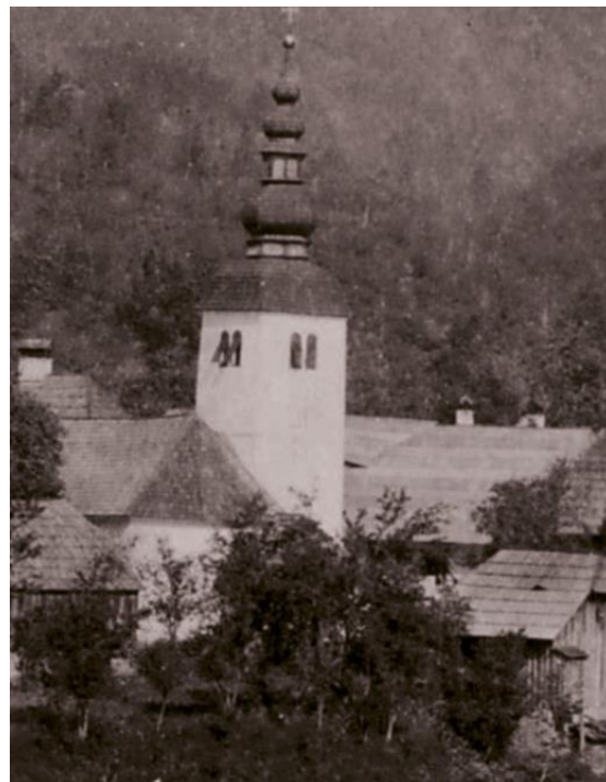
Slika 557: Streha pleškega zvonika, pokrita z malimi deščicami in delno obitega s trakovi bleščče pločevine. Desno, leseno gospodarsko poslopje ali hiša s straniščem; zadaj streha stare Šučave šiše iz 18- stoletja.
