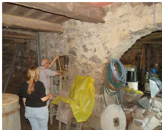
Slika 206: Polkrožni slop, ki povezuje sprednjo steno hiše z zadnjo konstrukcijo babe, ki je podpirala dimnično peč ali ognjišče?
