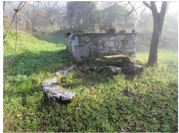
Slika 42: Kamnito podstenje sušilnice za sadje z obzidanim kuriščem v sprednjem delu in polkrožno kamnito klopjo levo. Manjka le leseno nadstrešje.
