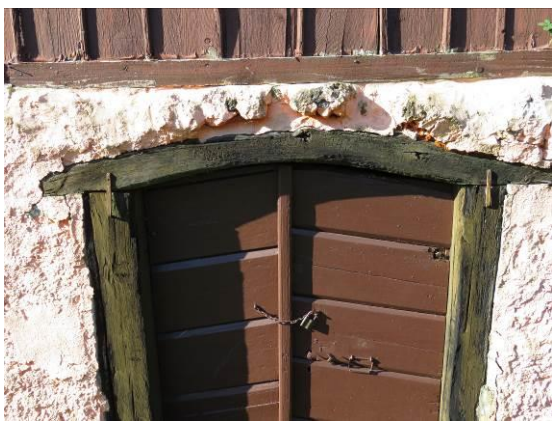
Slika 67: Funkcionalno in estetsko izveden sicer skromni leseni portal štale, ki kljub krhkosti konstrukcije poudarja njeno trdnost in premišljenost. Pravi, skrbno prebrani kos lesa na pravem mestu.
