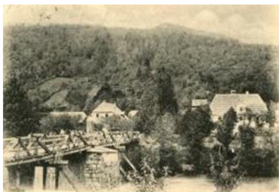
Slika 137: Stari most preko Kolpe od Broda do Petrine, na kamnitih stebrih pred drugo vojno.
