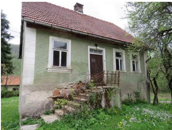
Slika 164: Tipična stanovanjska zgradba meščanskega izgleda iz začetka 20. stoletja, kakršnih zasledimo veliko po dolini Kolpe. S kovanim okrasjem ograje. Grajena iz opeke, z lesenimi hrastovimi stropniki nad kletnim delom, skromno notranjo opremo in ogrevanjem. Še vedno vrhhlevna.
