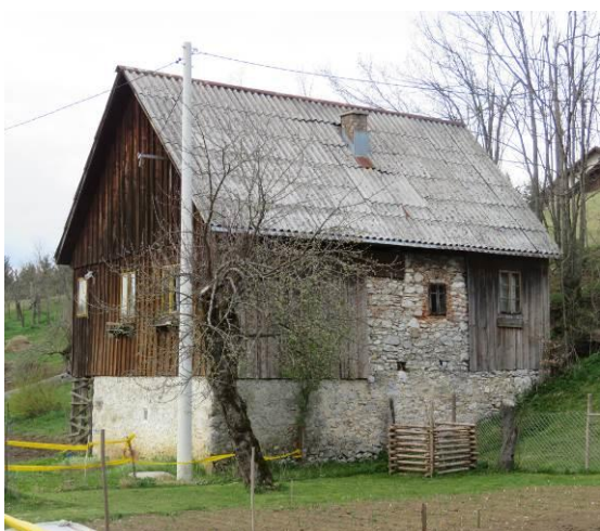
Slika 526: V Trbuhavi Dragi je takih hišic več. V kamniti steni se lepo vidi mesto kurišča, desno shrambni del in levo, sprednja lesena hiša.
