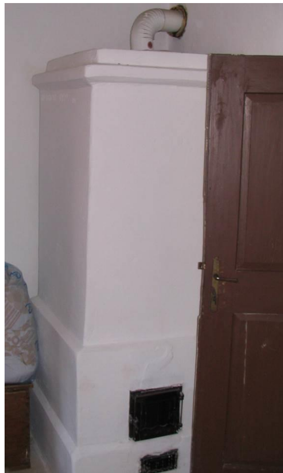
Slika 427: Peči na podstrehi so bile zgolj pozidane in ometane, brez pečnic.
