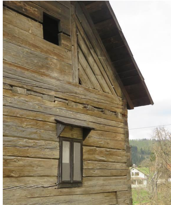
Slika 516: Konstrukcija lesenega zunanjega zidu v dveh etažah hiše Vesel. Štiristransko obtesane grede so spojene na nemški vugel.
