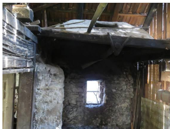
Slika 100: Napa iz lesenega opleta je ometana z glino in oprta na gredah; pod njo lesena palica za suho meso in zgoraj odprtina za dim, ki gre v podstreho. Zadnja stena z okencem je kamnita.
