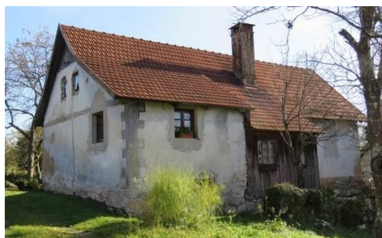
Slika 60: Starejša zidana hiša z nenavadnim prizidkom brez dimnika in masivnim dimnikom v sredini.
