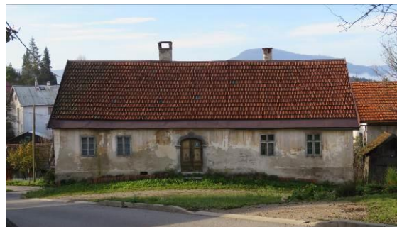
Slika 29 in 30: Večja starejša hiša s tipično osnovo pred 19. stoletjem: vhod v stanovanje je pravokotno na cesto, s ceste dva vhoda v kletni gospodarski del.
