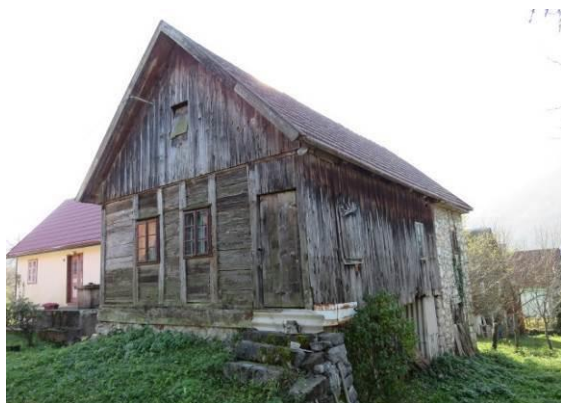
Slika 63: Ena od lesenih stavb s pokritim gankom; novejša, predalčne konstrukcije z vertikalnimi polji. Konec 19. ali začetek 20. stoletja. Zadnji del zgradbe je zidan.
