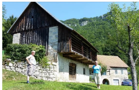
Slika 195: Domačija Pr Petrovih v spodnjem Zagoliku, spredaj novejši skedenj in zadaj starejša stanovanjska hiša.
