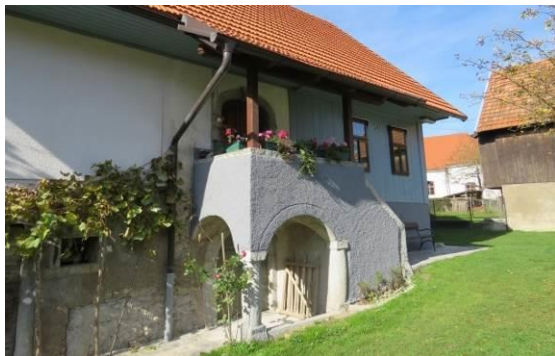
Slika 81: Gank, postavljen na kamnitih stebrih, pod njim vhod v klet.
