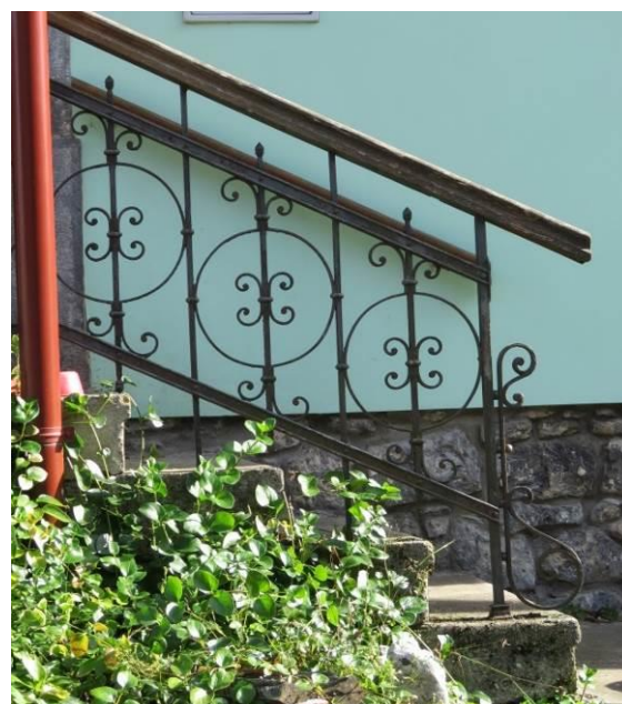
Slika 107: Ena redkih kovanih ograj v vasi. Podobne lahko vidimo v Velikih Dragah in v vaseh zgornje kolpske doline do Plešč. Po ustnih podatkih naj bi bile izdelane v kovačiji na Brodu na Kolpi okoli leta 1900 in kasneje.
