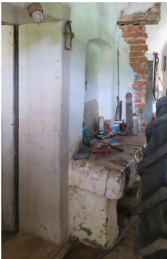
Slika 346: Ozka, masivna kamnita polica pred odprtino za nalaganje krušne peči, na kateri se je kuhalo na odprtem ognju čez poletje. Pozimi verjetno globje v peči.
