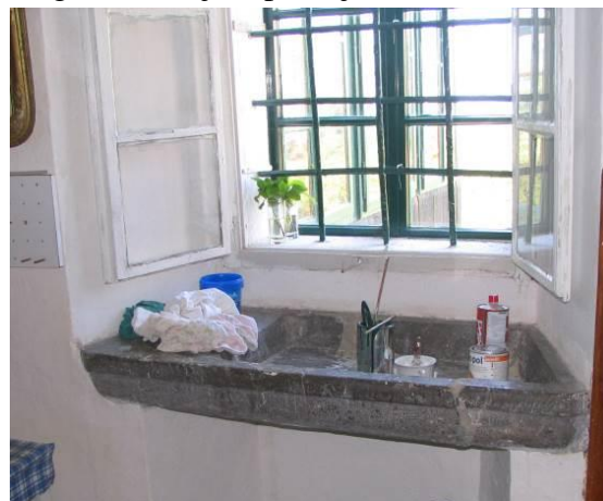
Slika 405: Mala sobica s krušno pečjo, v kateri se je tudi pralo in pomivalo, je imela pod oknom vgrajeno kamnito izlívko .
