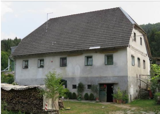
Slika 355: Starejša hiša poleg prejšnje je precej bolj čokata, dvotraktne zasnove z osrednjo vežo. Zgrajena do sredine 19. stoletja.
