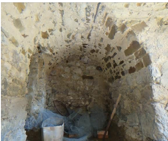
Slika 302: Polkrožni obok v malem dostopnem hodniku do kleti za mošt je bil izdelan iz rjavega peščenjaka in oprt na apnenčaste zidove. Ni jasno zakaj je iz kamna iz doline. Morda zaradi popravila po vojni?
