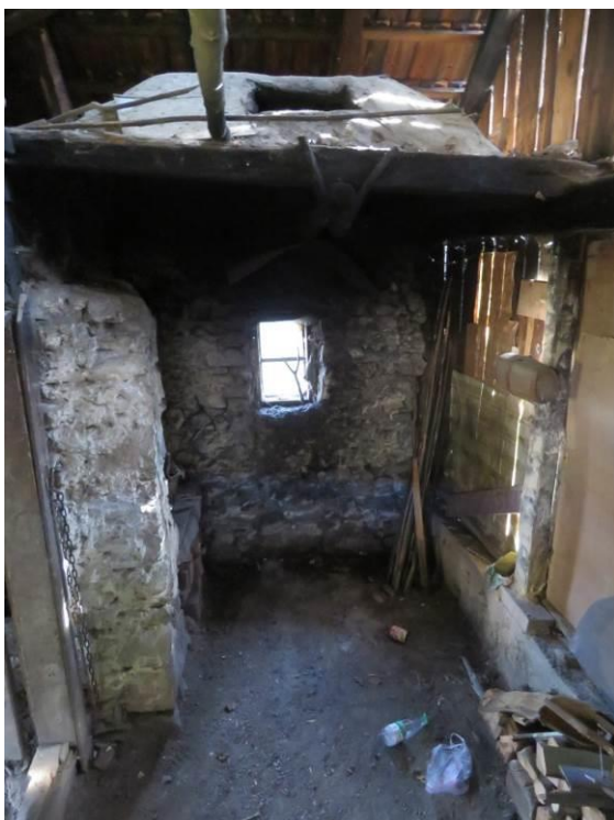
Slika 99: Predprostor s kuhinjo, z glinenimi tlemi, desno drva; levo je vhod v hišo ter predelna stena proti ognjišču z ognjiščem na plitvi kamniti polici pred pečjo. Zgoraj kapa za iskre.
