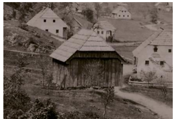
Slika 461: Skedenj v Goračih, enake konstrukcije in razmerij kot v Dragarski dolini. Ker je postavljen v breg, je spodaj hlev. S sprednje strani proti cesti je imel še prislonjeni kozolec. Podoben skedenj je bil tudi pri Grajskih v Pleščih.
