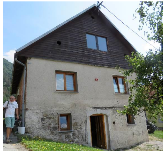
Slika 294, 295: Nakuančna hiša s sprednje in zgornje strani, s kamnitima portaloma. Leseni del je bil po vojni pozidan z opeko. Okna v nadstropju so bila povečana in izvedena na novih mestih.
