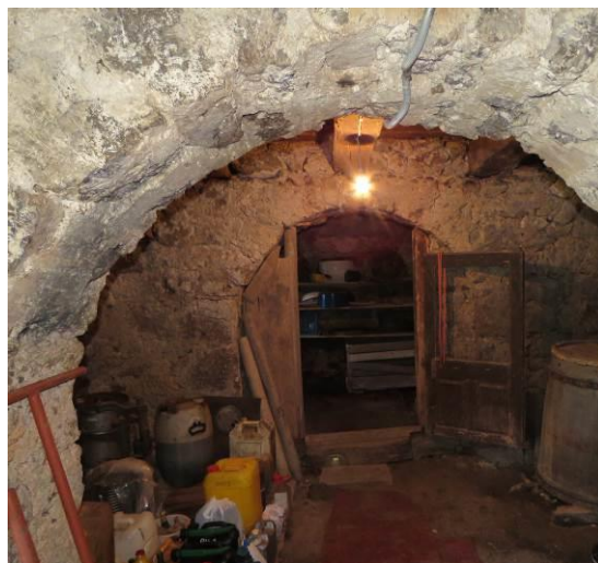
Slika 207: Pogled pod babo na polkrožni vhod v obokano klet za mošt (kasneje krompir). Morda so te kleti tisti prizidki, ki smo jih videli na katastru v Kuželju?
