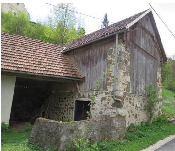
Slika 237: Značilno gospodarsko poslopje s štirimi masivnimi kamnitimi stebri, ki nosijo leseno konstrukcijo. Postavljeno verjetno pred 1861. letom, del gospodarstva prej prikazane hiše.
