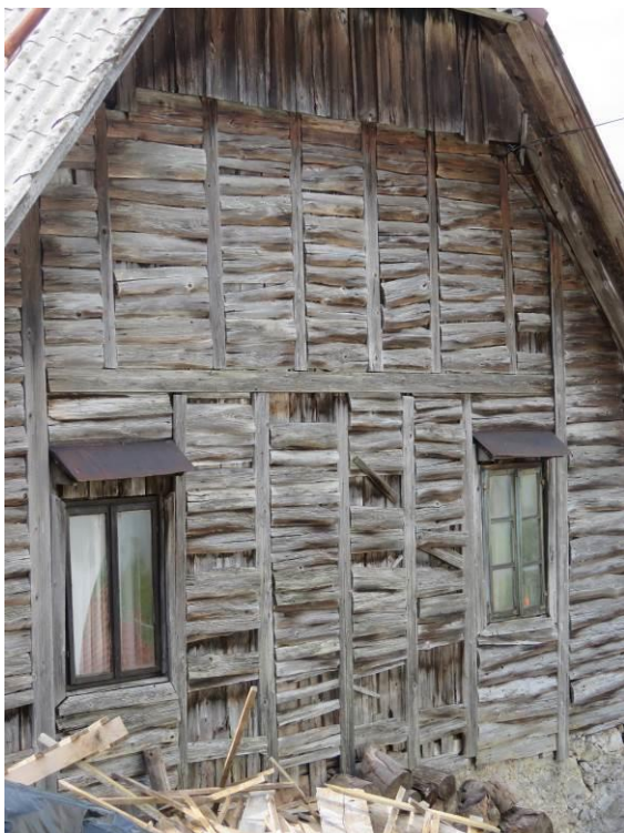
Slika 530: Nenavadna izvedba polnil za zaščito lesene konstrukcije hiš v Prezidu. Morda iz odpadnega materiala – odrezkov žage?
