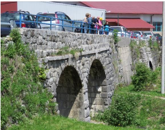
Slika 17: Gradnja Luiziane je pripeljala v Gorski kotar tudi mojstre kamnoseke iz Primorja, ki so bili sposobni zahtevnejših kamnitih konstrukcij. Na sliki viadukt v Lokvah. Nekaj jih je tu tudi ostalo in so nadaljevali gradbena podjetja – eni od njih so bili mojstri iz družine Lenac iz Senja, ki so nov dom našli v Bosljivi Loki.
