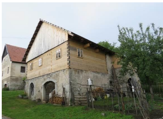
Slika 116: Hiša Ožanić z zadnje strani, kjer je desno dozidan masivni kamniti del, ki se zaradi statične ojačitve opira na hišo.
