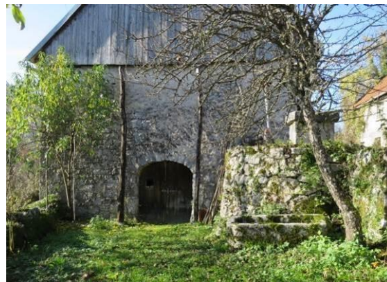
Slika 66: S kamnom obdelani zidovi pri vhodu v hlevski del enega od starejših gospodarskih objektov, na parceli 343 nad nekdanjim vaškim kalom. Desno stoji štirna in pod njo na vhodnem platoju v hlev kamnito korito za napajanje živine. Palice ob kamniti steni izdajajo, da so nekdanj nosile vinsko trto, ki se je vzpenjala ob južni kamniti steni poslopja.
