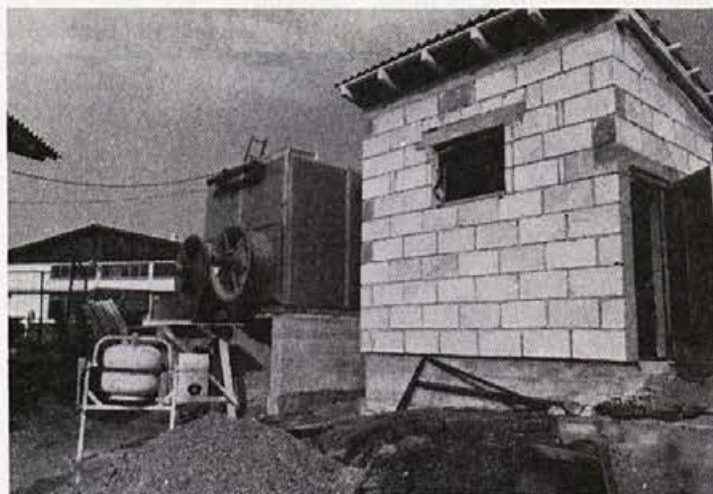
Dograditev sistema hladilne vode
