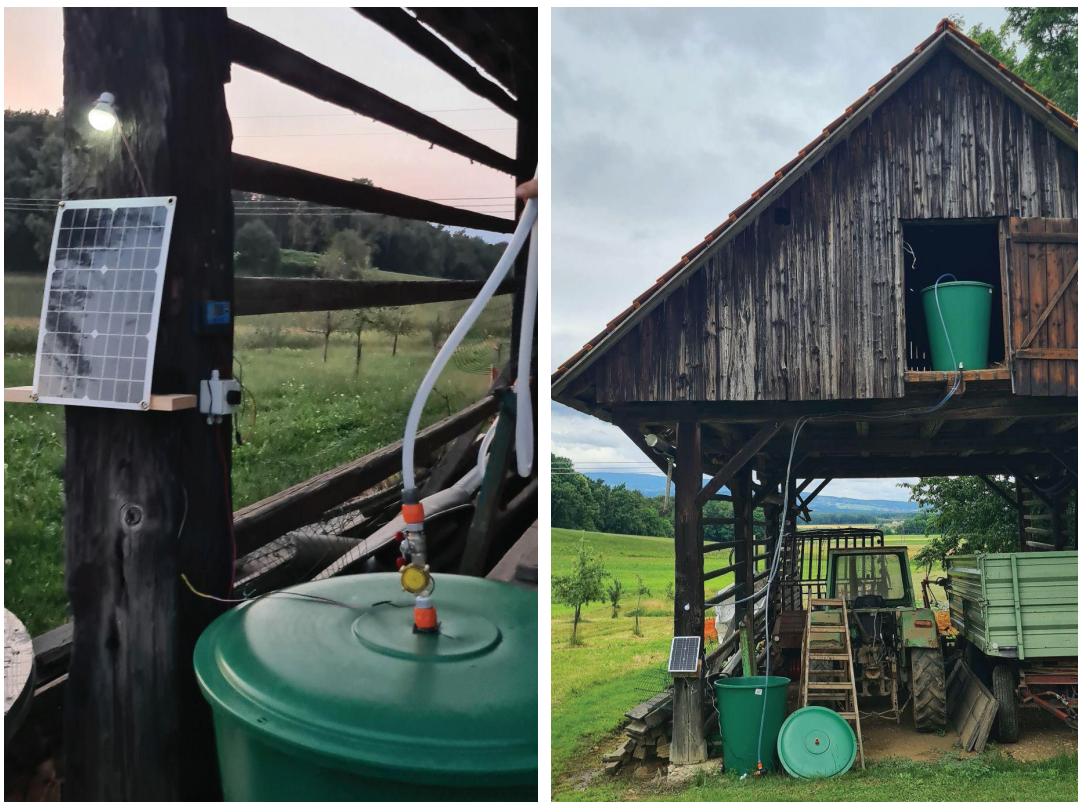
Slika 29: Nameščena gravitacijska baterija
