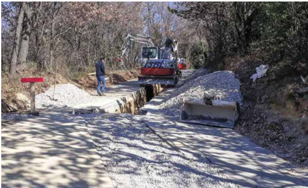
Gradbena dela v Ankaranu bodo trajala celo leto. / I lavori edili ad Ancarano dureranno tutto l'anno. (Foto: Občina Ankaran / Comune di Ancarano)
