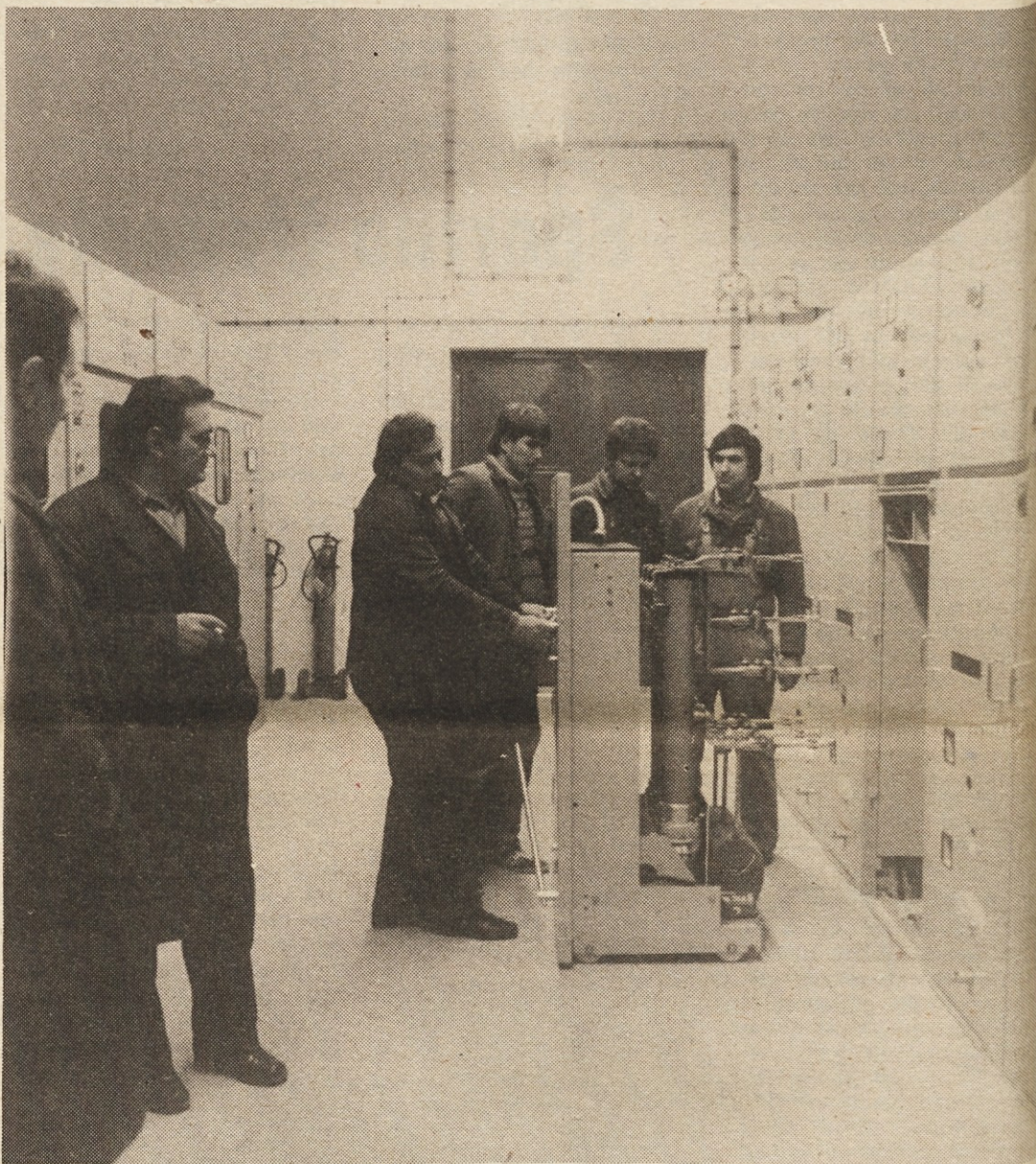
MARIJA PRIMC Zadnja dela na visokonapetostnem izvlačljivem stikalu.
