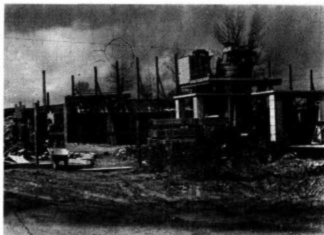
Montaža strojne opreme nove betonarne
