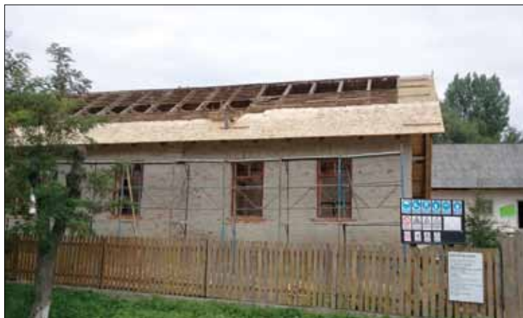
Pokrivanje strehe tik pred zaključkom del
