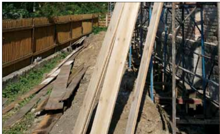
Priprava ohranjenega ostrešja za uporabo na novi strehi
