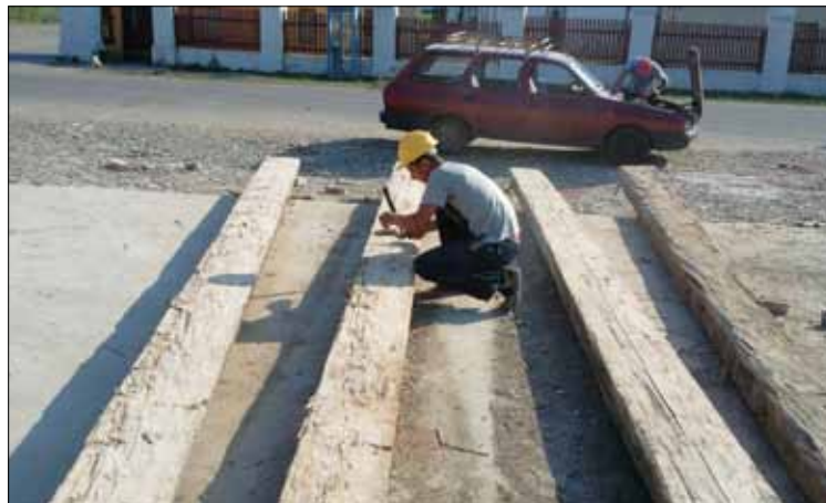
Priprava ohranjenega lesa iz ostrešja za strukturne nosilce
