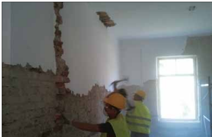
Odstranjevanje stenskih ometov
