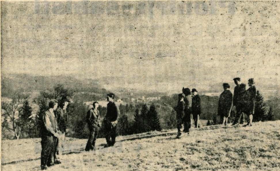
Ob otvoritvi vodovoda na Okroglem: Eno delo je opravljeno, čaka nas drugo, pravijo prebivalci prijazne vasice pod Kamniškim vrhom, ko si ogledujejo teren, kjer bo tekla cesta
