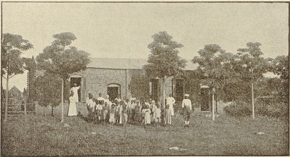
Missionschule in Bau.
