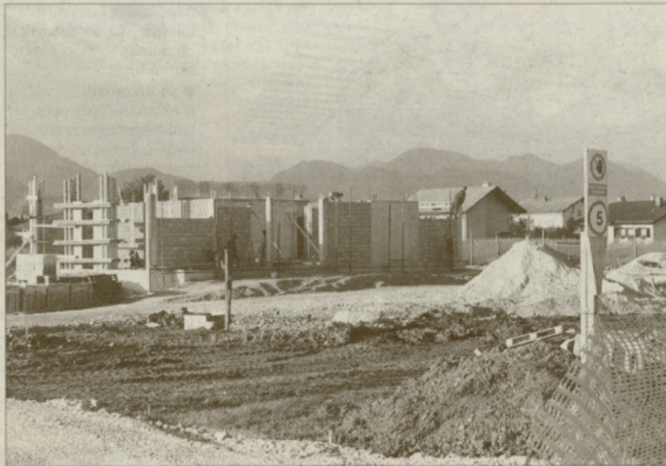
Gradbišče bencinskega servisa.
