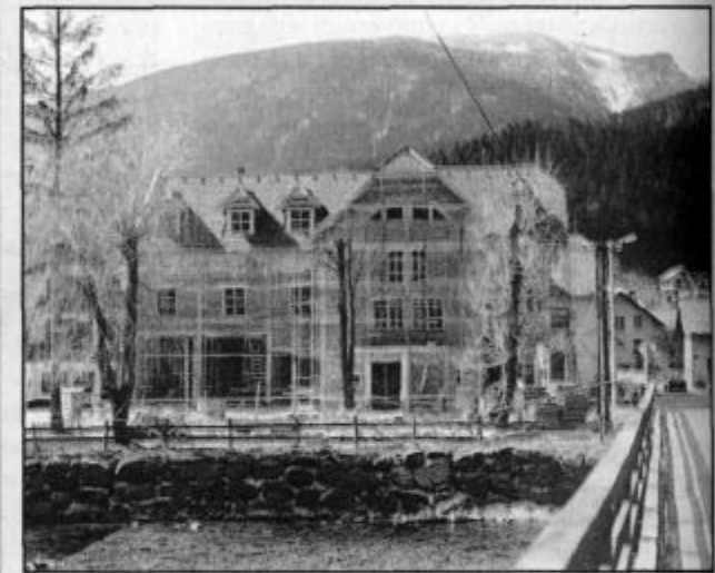
Večnamenska stavba je za Luče velika pridobitev
