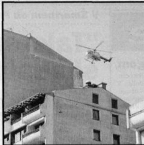
Helikopter je na teraso dvignil vse potrebne plošče hitro in enostavno.
