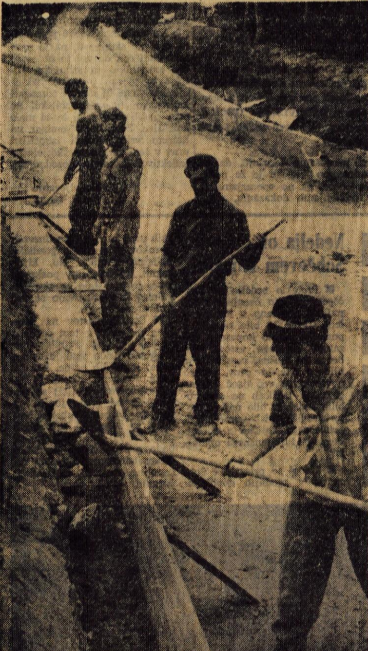
V Predosljah delajo betonski oporni zid, ker je zemlja polzela na cesto, ki vodi v naselje
