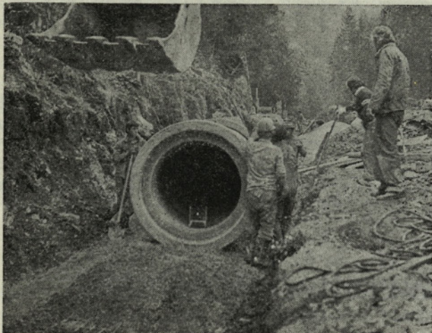
Slika 3. Gradnja kanala s centrifugiranimi cevmi Nivo
